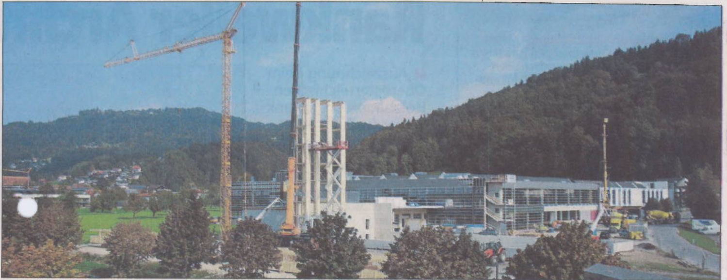
Gestern spätnachmittags waren die ersten vier Träger des künftigen Holz-Hochregallagers aufgerichtet.
